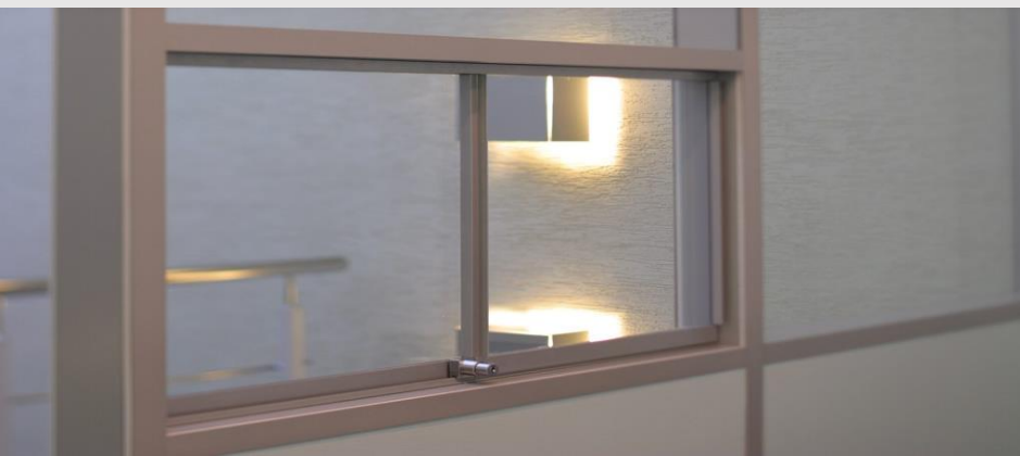
Установка в перегородку передаточного окна
